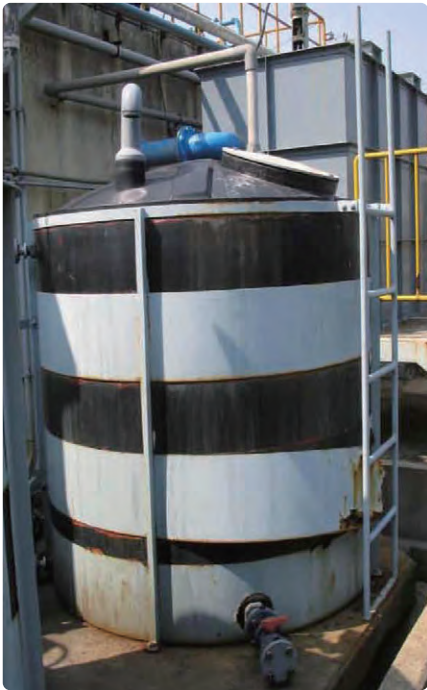
タンクの撤去・据付。 配管工事もお任せください。
